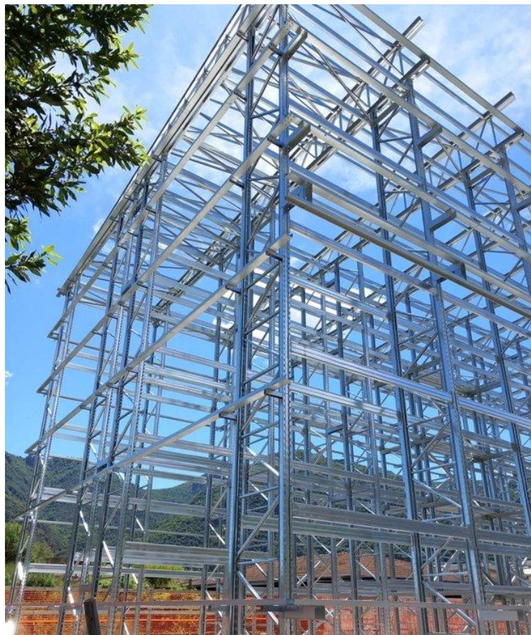
Impianto in fase di montaggio
